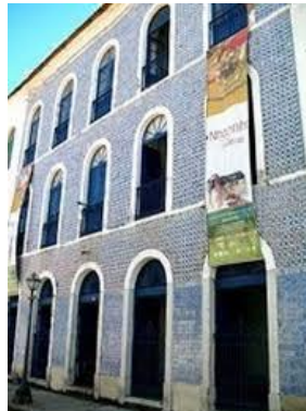
Figura 6 - Fachada da Casa de Nhozinho
