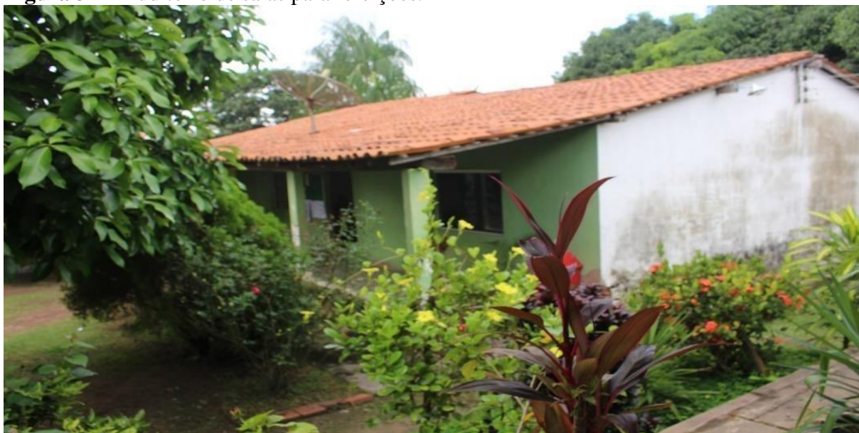
Figura 34 – Auditório de salas para refeições.
