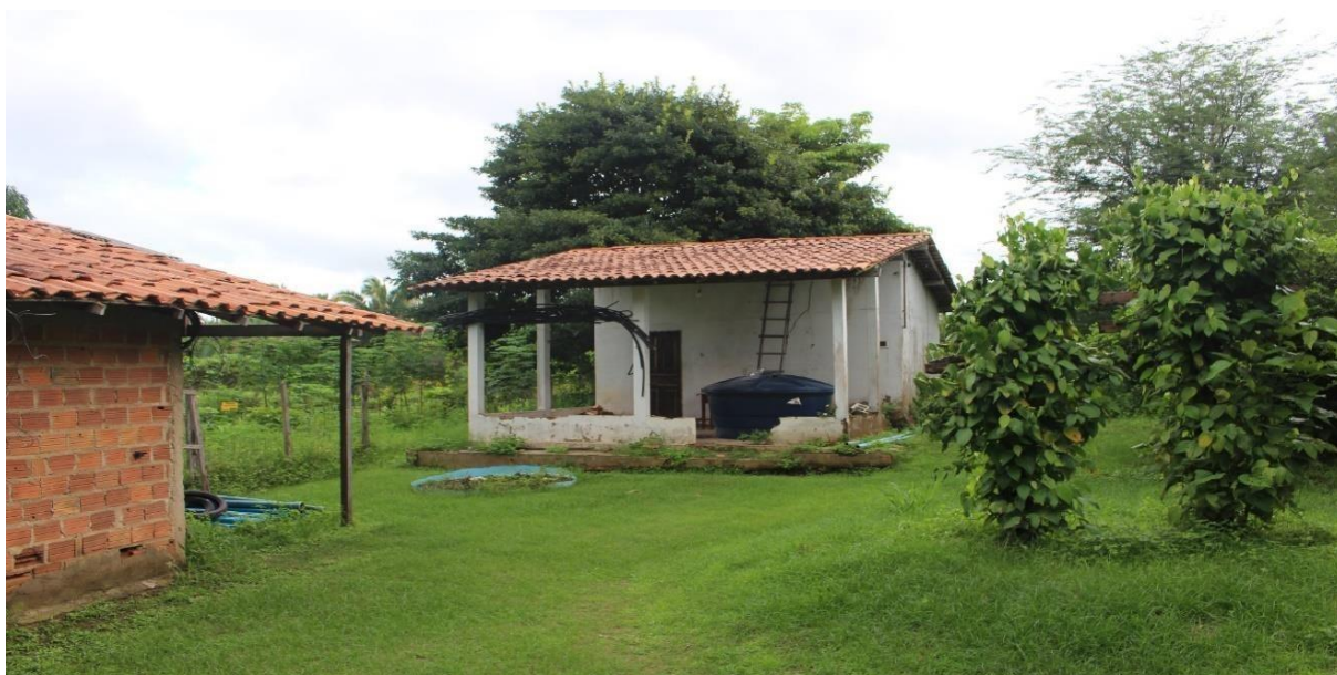
Figura 8 - Local onde fica guardado as ferramentas e equipamentos agrícolas.
