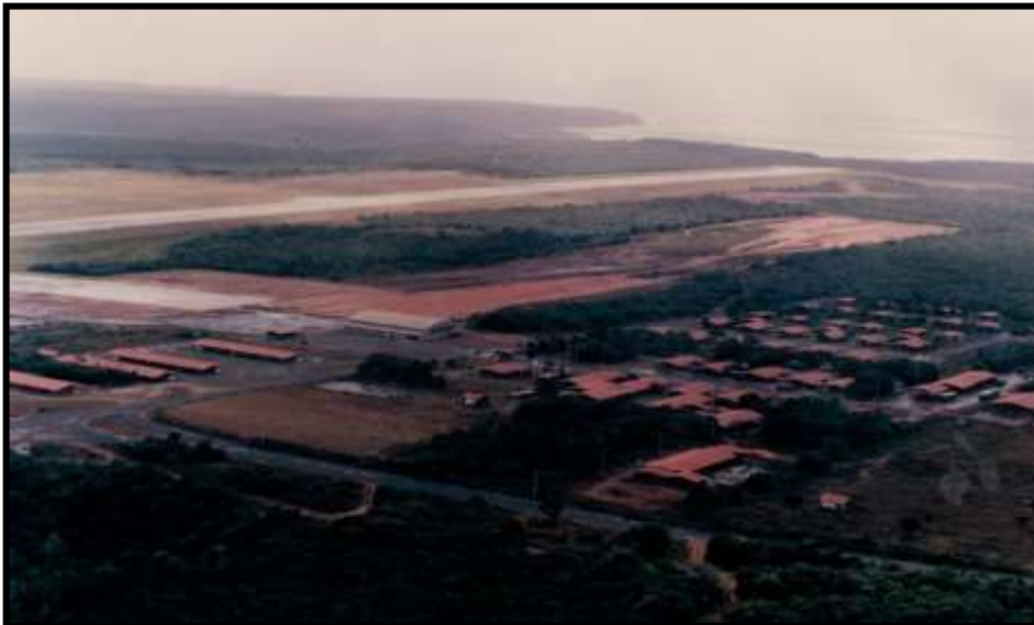
Foto 16- Área II: construção da pista de pouso, alojamentos e Vila Militar
