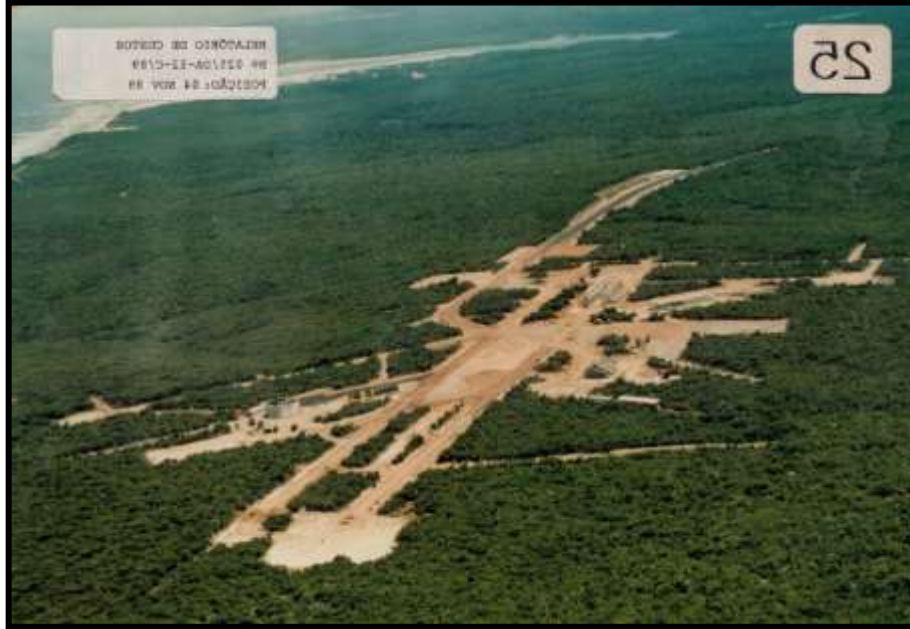
Foto 15- Área I: construção do Setor de Preparação e Lançamento
