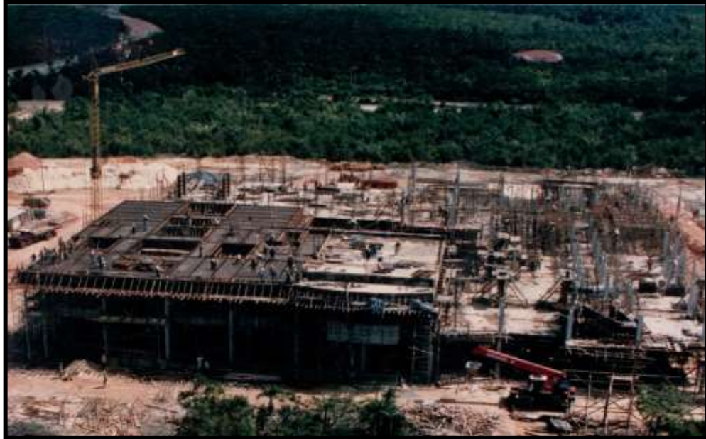
Foto 17- Área II: construção do Centro Técnico
