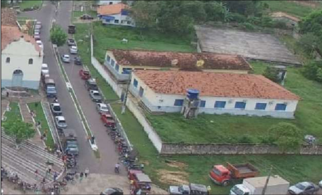
Figura 04 -Imagem aérea da escola antes da reforma ocorrida em 2018-2019.
