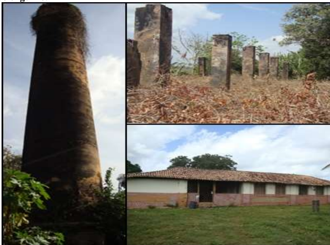
Figura 36-Chaminé, ruínas da Usina e estrutura da antiga Gerencia admirativa do engenho.
