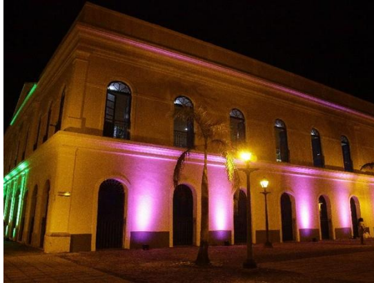
Figura 4 - Fachada da Casa do Maranhão
