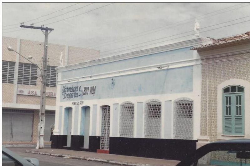
Fig.36 - Fachada da residência da família Lôbo FONTE: Acervo particular da autora
