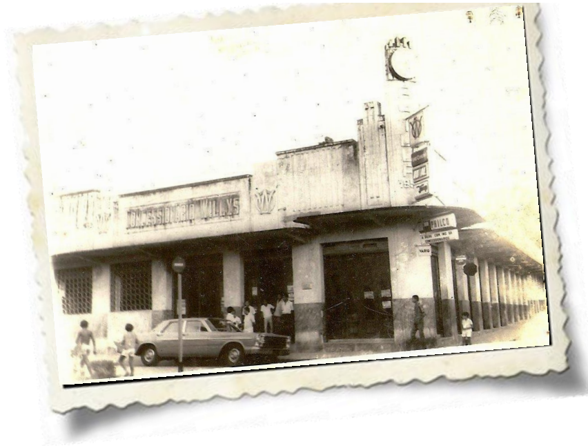
Fig. 70-Armazém Caxias Fonte: autor desconhecido
