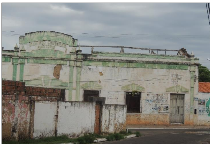
Fig. 40. Fachada do Colégio Caxiense fundado em 1937
