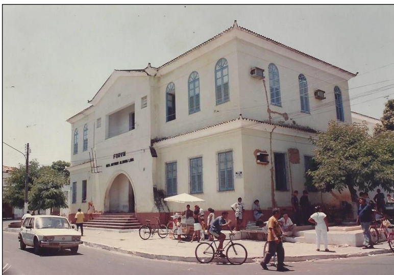
Fig. 33 – Prédio do Antigo Fórum FONTE: Acervo particular da autora
